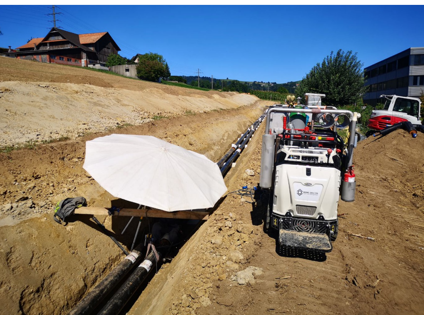
Heizzentrale Blegi Leitungsbau
